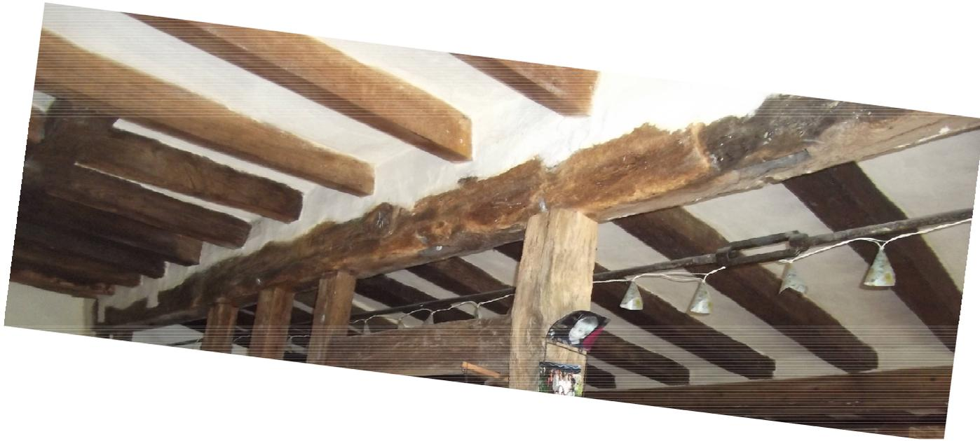
avec un chargement de la charpente de l'étage : reprise de l'entrait bas, lequel fait transiter la charge de toiture sur le solivage en zone C1 (décalage de quelque cm de la poutre par rapport à la ferme), de :
