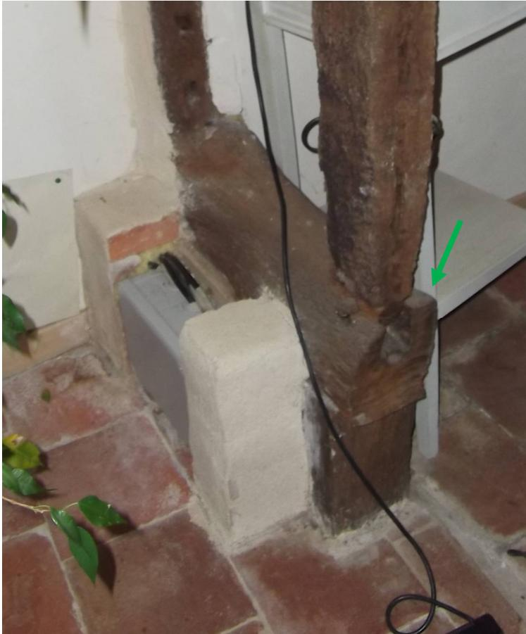
> poutre sur appuis multiples et sans appui aux extrémités : les poteaux noyés dans les murs, ne peuvent pas assurer une fonction porteuse de la poutre (cf. NdC). En effet, les largeurs minimales des appuis aux extrémités de la porteuses, sont insuffisantes pour considérer la poutre en appui selon le code CB71 (doivent être de 40 mm minimum).
