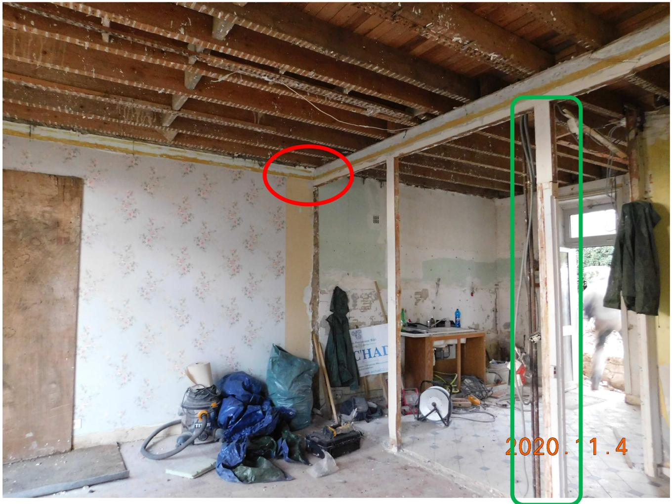
On notera la poutre porteuse actuelle du plancher haut du RdC : à l'origine une cloison bois comblée de briques plâtrières.
